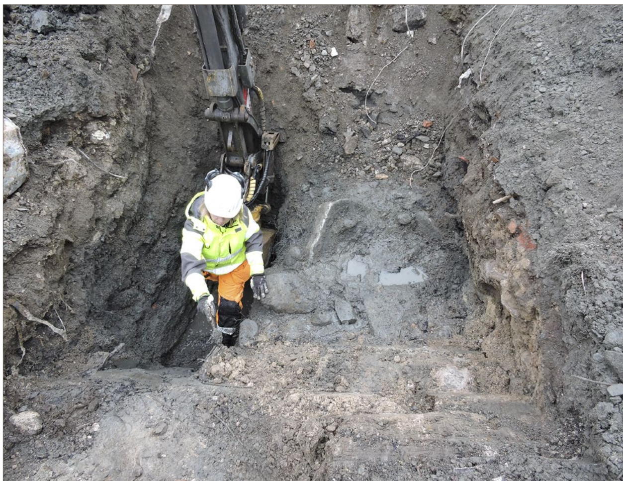
Figur 14. Pia Svensson rensar fram stenkonstruktionen i schakt 8. Foto: Mattias Öbrink.
